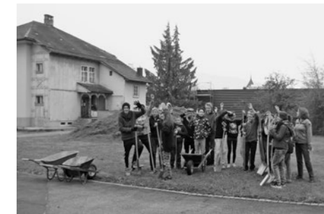
Mit vereinten Kräften wird ein Loch für das Fundament des neuen Basketballkorbs ausgehoben. (Bild: Gemeinde Unterkulm)
